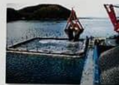
浚渫戻し事業
