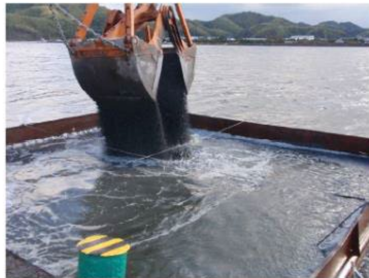
▲汚濁防止枠内へのHiピース投入 所定の厚さに覆砂するため、枠内を4分割し、投入回数を定め 実施。(投入バケットのサイズ: ○ m 3 )
