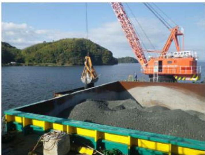
▲③起重機船によるHiピース覆砂
