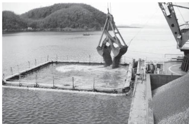
写真4 石炭灰造粒物による窪地の覆砂実証実験
